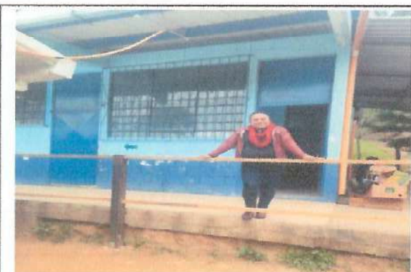
Foto 3: Mejoramiento de la estructura de barandas
