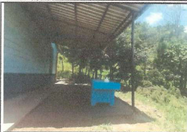
Foto 1: 1. Mejoramiento de la estructura de la galera para la cocina
